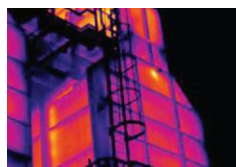
石油精錬所におけるガス漏れ
