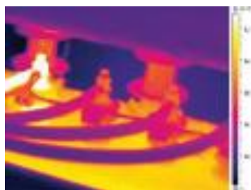
パイプのつまり
