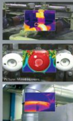
絶縁不良のため蒸気がパイプから漏れていることを示すフュージョン機能によるイメージ 過熱した遮断器を示すフュージョン機能によるイメージ
